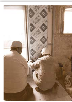
③断熱材をはめ込む
