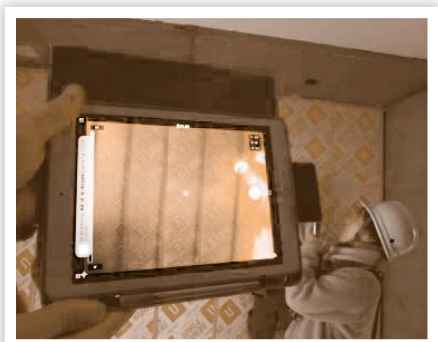
④サーモカメラで断熱材を施工した効果を確認!
