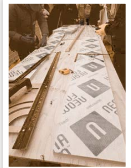
②断熱材をサイズに合わせてカット
