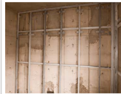
①最初に木枠を設置
