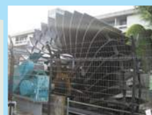
家中川小水力市民発電所「元気くん1号」 (山梨県都留市)
