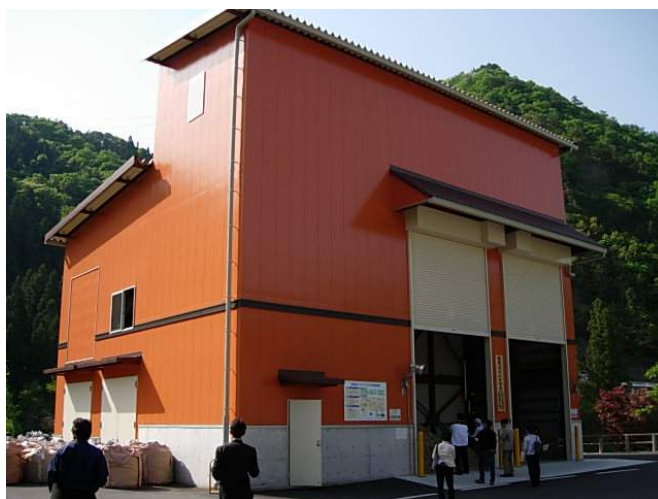
図表 3-75 ちちぶバイオマス元気村発電所
