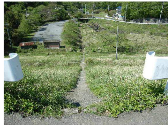
堤頂部の中央付近から下流側
