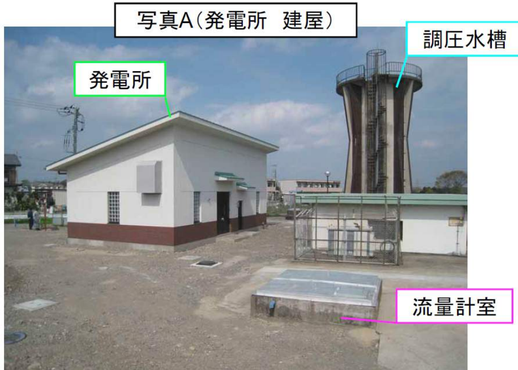
図表 3-42 発電所写真
