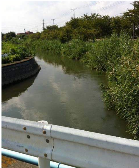
図表 3-29 備前渠用水路（深谷市老人福祉センター福寿荘付近）
