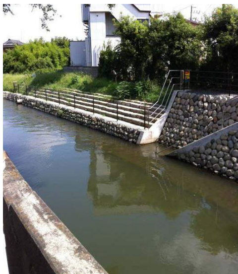
図表 3-31 備前渠用水路（深谷市役所浄化センター付近）
