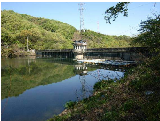
右岸ダム湖側
