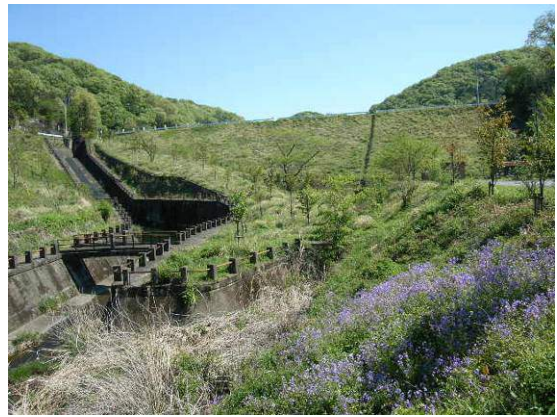
下流側から見たダム堤体
