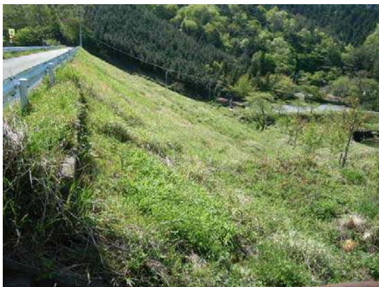
右岸側から見たダム堤体下流側の様子
