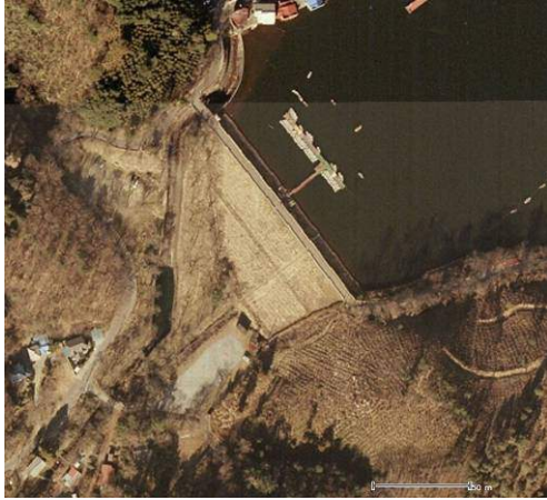
南側にあるダム堤体
